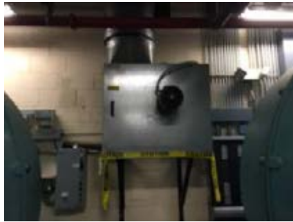
Combustion Air Fan
